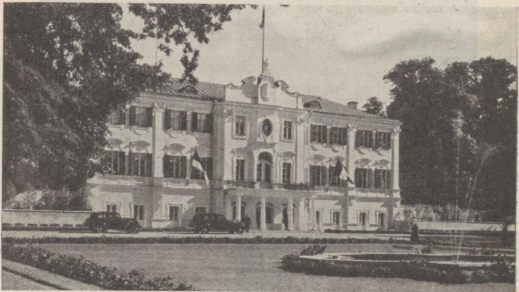
Parikaste foto. 104. joonis. Kadrioru lossi esivaade.
