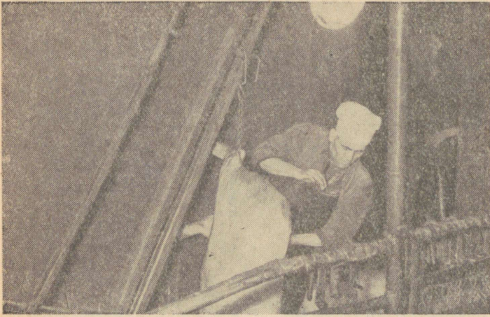
Joon. 14. Peekonisiga saadetakse tagumist jalga pidi ülesriputatult kett-transportööri abil torkamisruumi.
