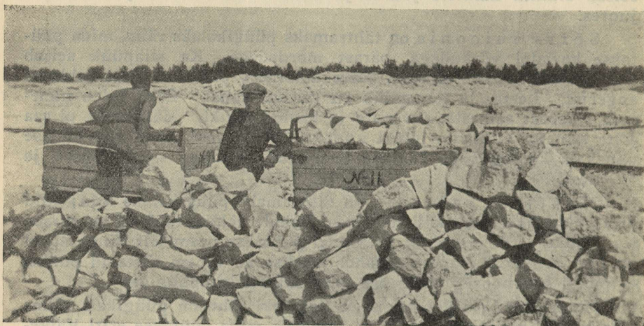
84. joonis. Lubjakivi laadimine koduraudtee vankritele sadamasse viimiseks Jaagarahu kivimurrus.
