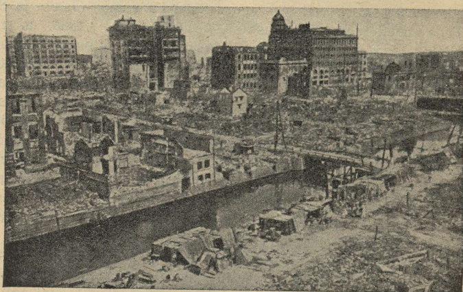
33. joonis. Tokio pärast 1923. a. maavärinat. Pange tähele rusuhunnikuid ja purunenud ning viltuvajunud raudbetoonist „pilvelõhkujaid“!
