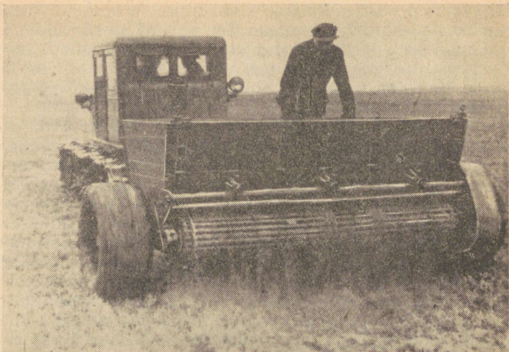
Joonis 30. Taimekasvatuse Instituudi mehhaniseerimise sektori poolt konstrueeritud lubja-külvimasin töös.
