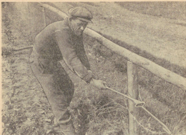
Joonis 32. Okastraadi pingutamine konksu ja sedelgarihma abil (Tähtvere katsebaas).
