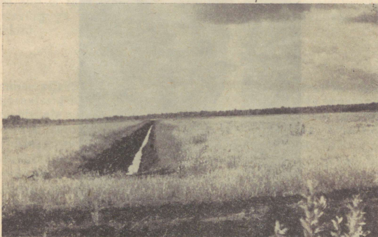
Joonis 12. Kuivendusobjekt «Lembitu» kolhoosis. Kuivenduskraavid on rajatud ekskavaatoriga.
