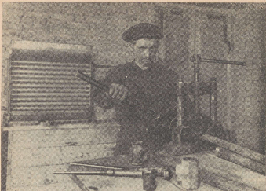
Joonis 18. Kadrina traktorijaama lukksepp J. Saugla Tapa rajooni «Kalevi» kolhoosis piimajahuti ülesseadmist lõpetamas.
