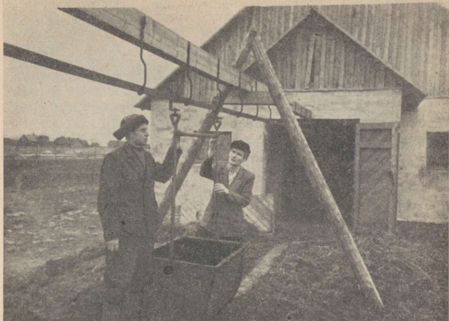
Joonis 14. Rippraudtee ülesmonterimine Kiviõli rajooni «Ühisjõu» kolhoosis. Paremäl Lüganuse traktorijaama vanemmehaanik E. Korsten, vasakul kolhoosi juhatuse liige A. Soome.
