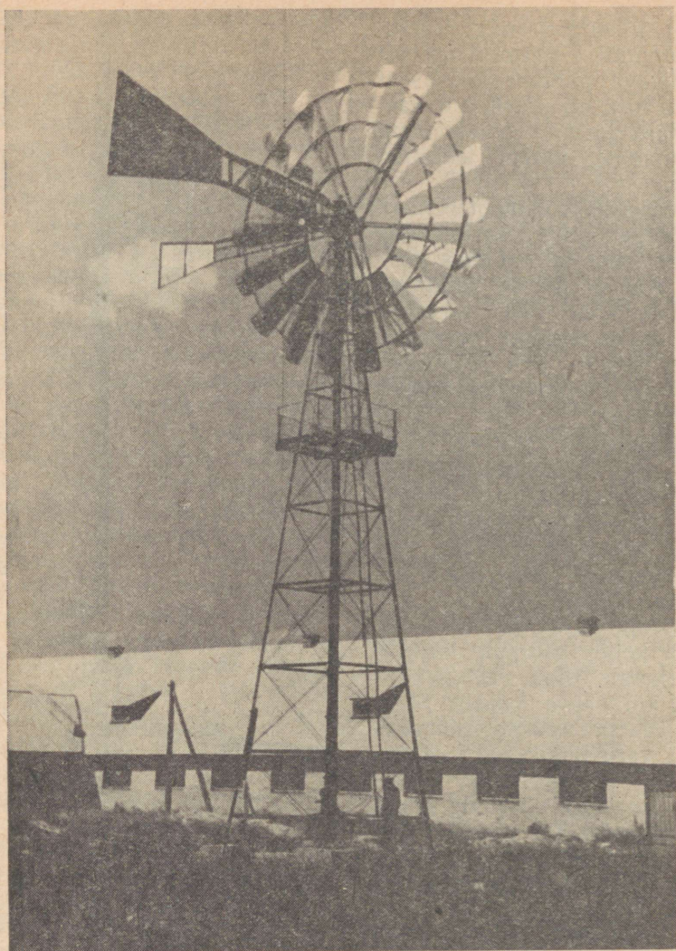
Joonis 2. Paide rajooni Stalini-nimelise kolhoosi tuulemotor TB-8.
