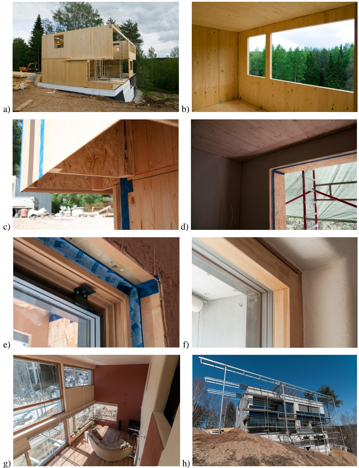
Joonis 6.2. Töö autori fotod arvutustes kasutatud hoonest: a) ristkihtliimpuitkilpidest valminud välisseinte kandev osa; b) vaade teise korruse lõunapoolsest magamistoast, näha ka ristkihtliimpuitkilpide sisekülg; c) välisseina soojustuse karkass; d) aknaavaus, näha ka soojustuse karkassi moodustatud akna välimine põsk; e) paigaldatud viimistlemata puitaken vaadatuna ruumist sees; f) lõplikult viimistletud puitaken ja aknapõsk; g) valminud hoone elutuba; h) hoone lõunafassaad.
