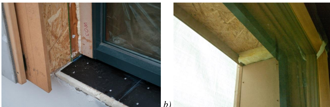
a) Joonis 6.10. Töö autori fotod aknapaigaldusest tööde käigus: a) avatud väline aknapõsk: soojustus ja katteplaat on lisamata, näha on C-tala OSB plaat; b) osaliselt avatud väline aknapõsk: küljel on näha katteplaat, ülemises osas soojustus.
