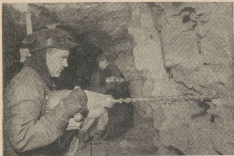
Joon. 33. Töö elektripuuridega põlevkivi kaevandamisel allmaakaevanduses praegusel ajal.
