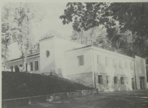
Foto 1. Patoloogikum, vaade Herne tänavalt (september 1996); sissekäik omastele ja surnute äraviimine (parempoolne lai uks).
