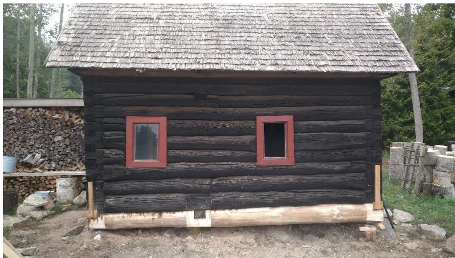
Pilt 11. Valmis töödeldud palk seinas (Allikas: töö autori foto)
