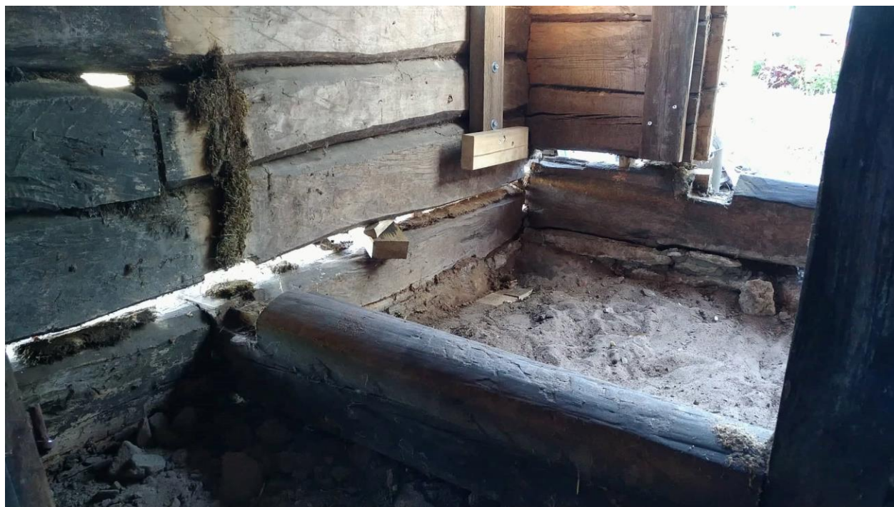
Pilt 6. Toestatud ja üles tõstetud Rannakivi saun (Allikas: töö autori foto)
