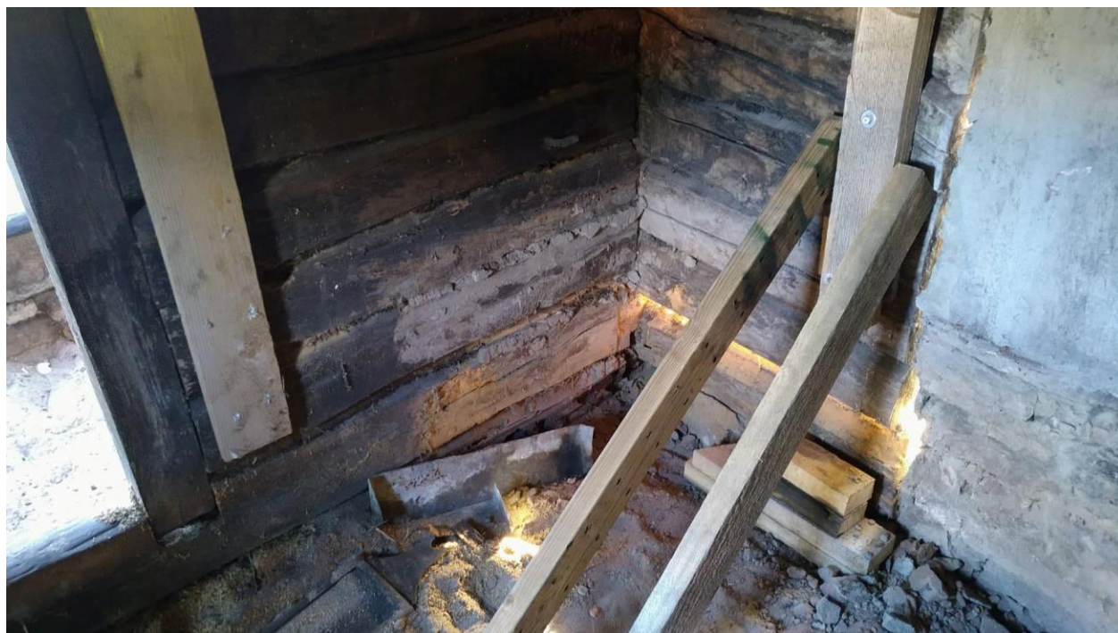
Pilt 7. Toestatud ja üles tõstetud Rannakivi saun (Allikas: töö autori foto)
