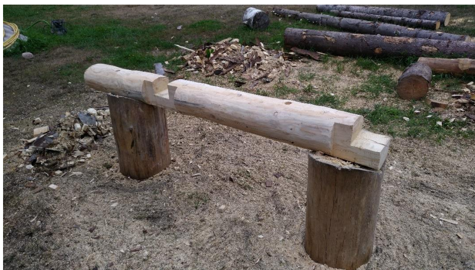
Pilt 10. Lõigatud välja palgi pähikud ja tapp (Allikas: töö autori foto)
