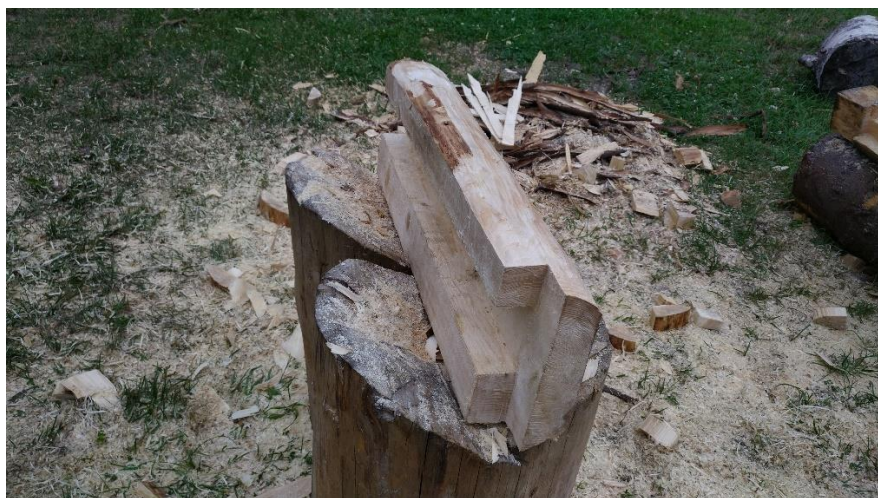
Pilt 14. Vaheseina alumise palgi plomm (Allikas: töö autori foto)
