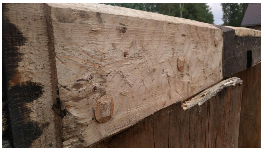
Pilt 16. Vaheseina alumine plommitud palk (Allikas: töö autori foto)
