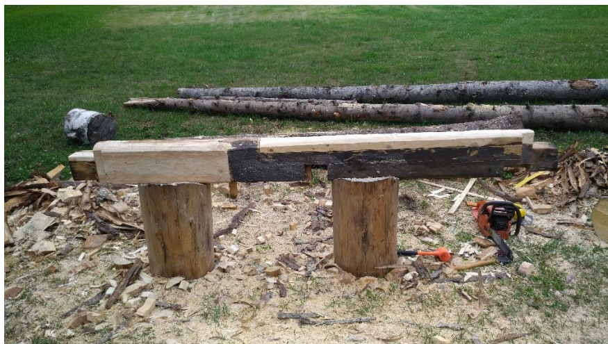
Pilt 15. Vaheseina alumine plommitud palk (Allikas: töö autori foto)
