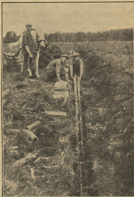
Savitorudrenaaz soos, Tooma Sookatsejaamas. Pildil näha ka puust alused kuhu asetatakse torud, et nad ei vajuks.
