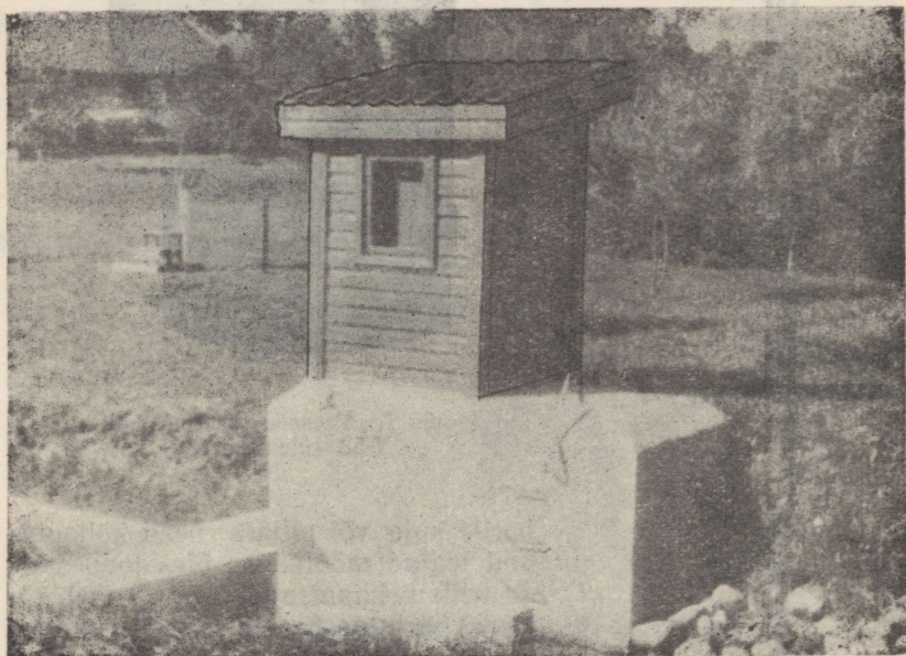
Joonis 8. Limnigraafi seadeldise ülevaade.
