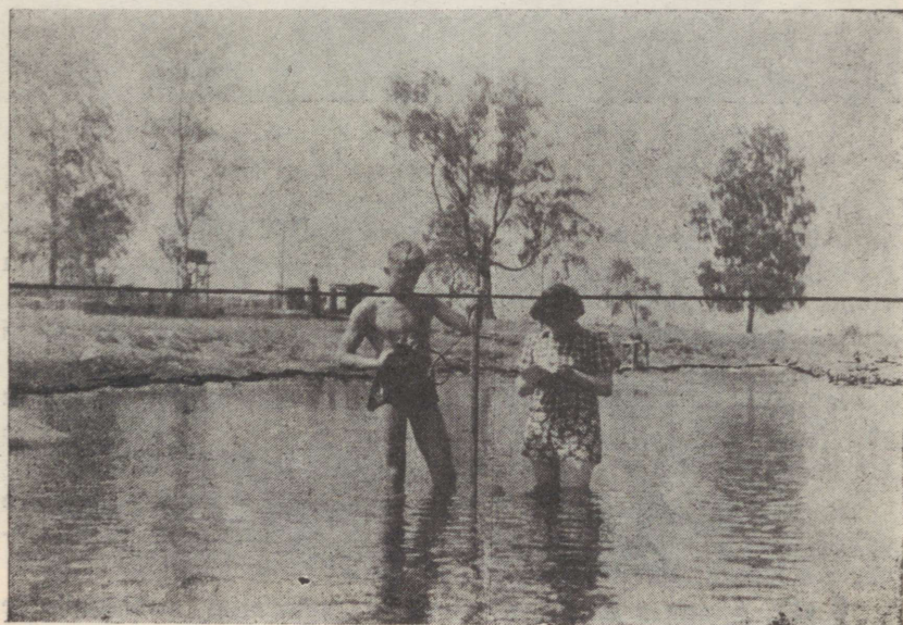
Joonis 41. Vooluhulga mõõtmine vees seistes.
