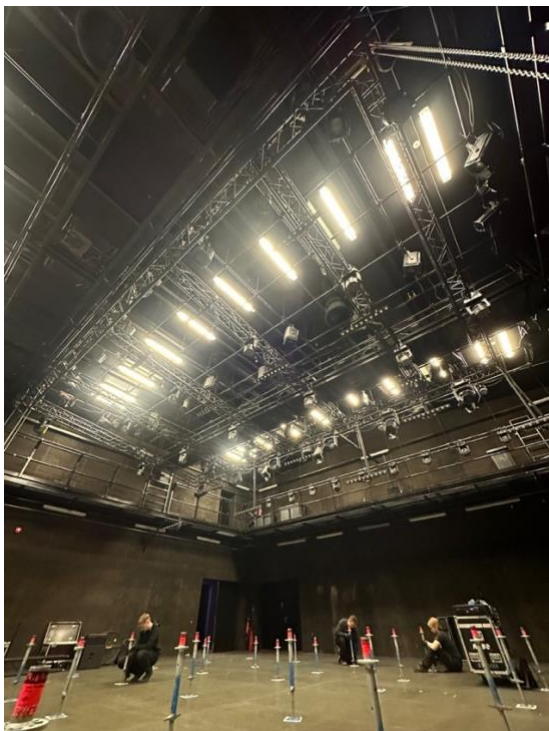
Joonis 12. Valminud trussiraam ning lavaehitus. (Foto: Mihkel Viinalass)
