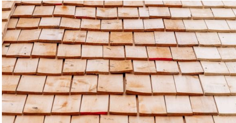
Joonis 29. Paigaldatud märja kimmi kuivamisega tekkinud külgvahed (Autor: Sandra Urvak)
