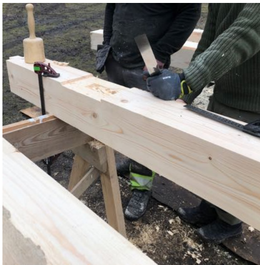
Joonis 23. ja 24. Konstruktsioonidetailide valmistamine (Autor: Mikk Tagapere)
