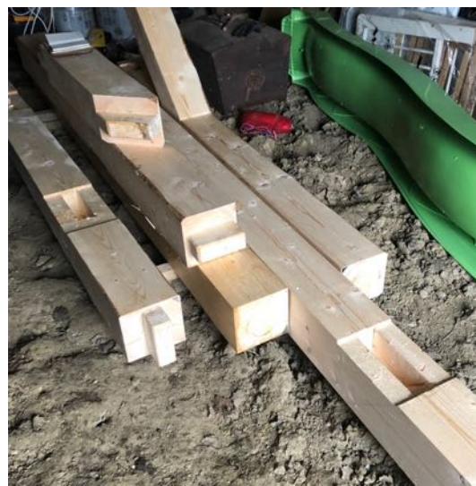
Joonis 23. ja 24. Konstruktsioonidetailide valmistamine (Autor: Mikk Tagapere)
