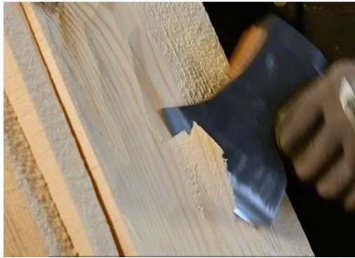
Joonis 9. Nähtava pinna tahumine (Nylund, 2024)
