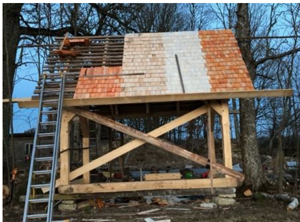
Joonis 31. Kimmide paigaldus katusele (M. Tagapere)
