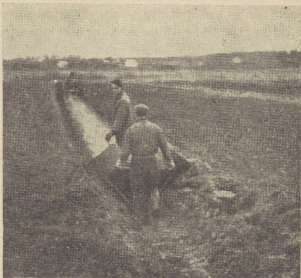
Traktörijõul kõiega veetav kraaviader põllukraavi puhastamisel.
