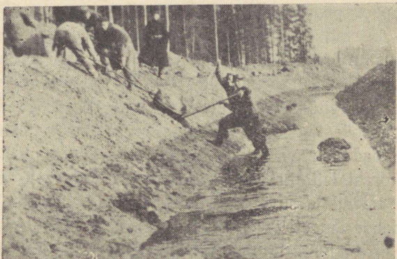
Kivide kõrvaldamine peakraavist inimjõul.
