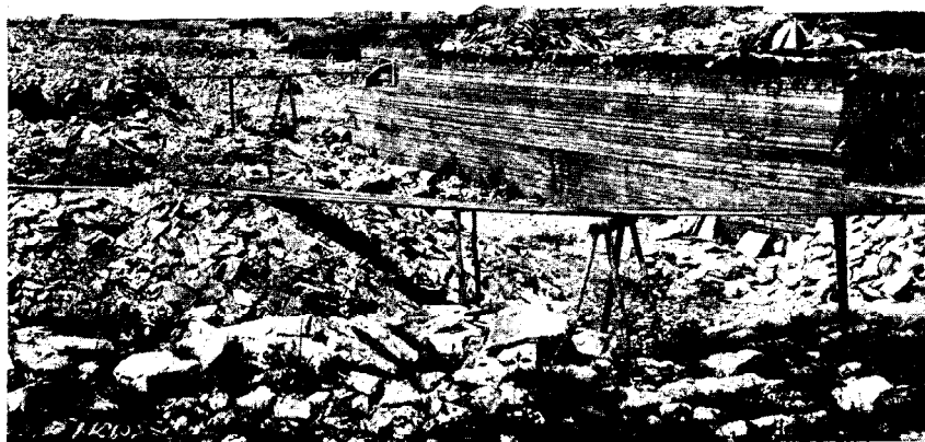
Fig. 2. Kalksteinbruch auf dem Linnaalood. Die horizontalen Schichten des Untergrundes sind sichtbar.
