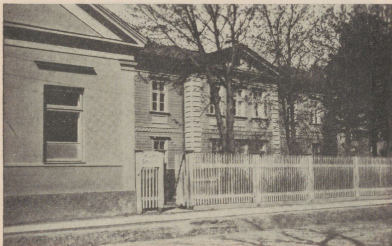
Silmakliiniku kahekordne puu-juurdeehitus ja sissekäik kliinikusse.
