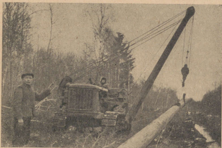
Joon. 39. Traktorkraana gaasijuhtme paigaldamisel.
