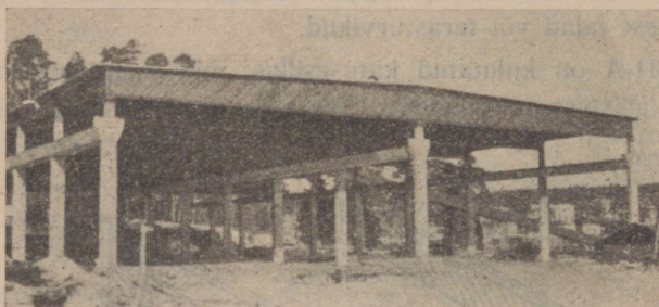
Joon. 135. Tööstushoone katuse tehases valmistatud I-kujulistest puittaladest. Ülal — katuse ehitus. All — üldvaade valminud katusele.
