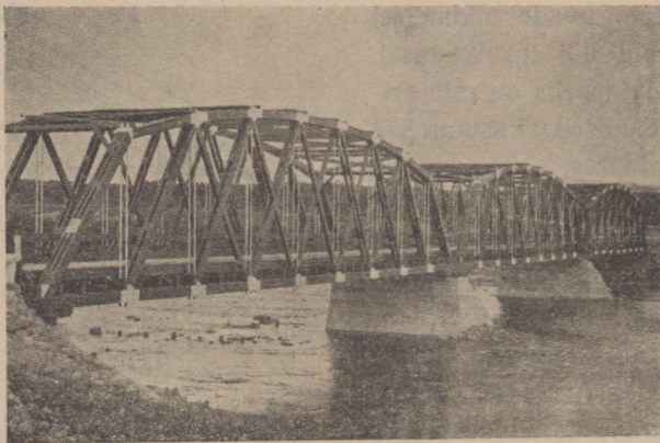
Joon. 84. Puidust maantee-sild. Valged püstvardad on terasest.
