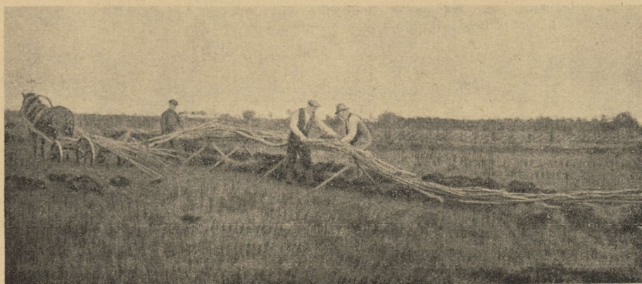
Jon. nr. 5. Lattide sidumine enne kraavi paigutamist.
