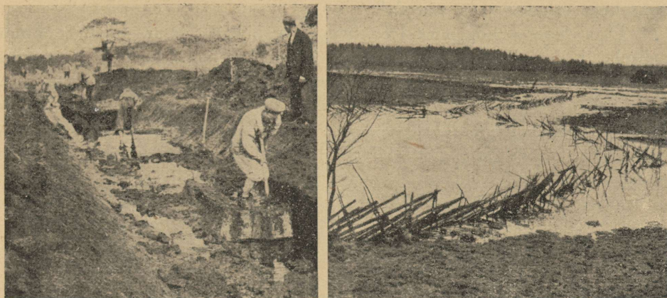
Joon. nr. 3. Adila pääkraavi kaevamine (pahemal). Pääkraavi ümbrus enne kuivendamist (paremal). (Põllumajand. Pääval. aastaraamat I.)
