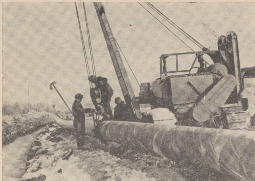
Joon. 96. Kohtla-Järve—Tallinna gaasijuhtme paigaldamine.
