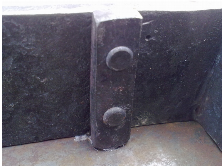
Foto 11. Kinnitustihvt korpuse külge needituna
