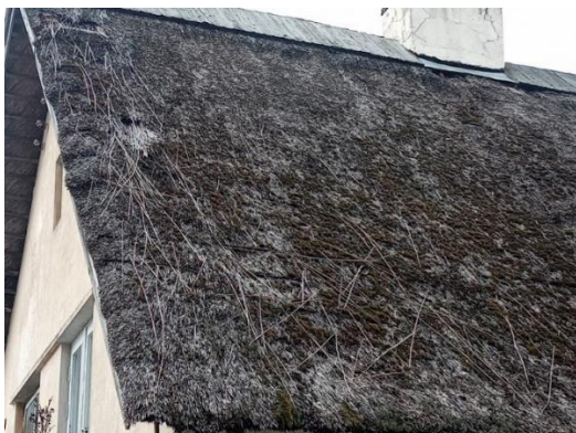
Joonis 39. Hoone idakülg. Autori foto.
