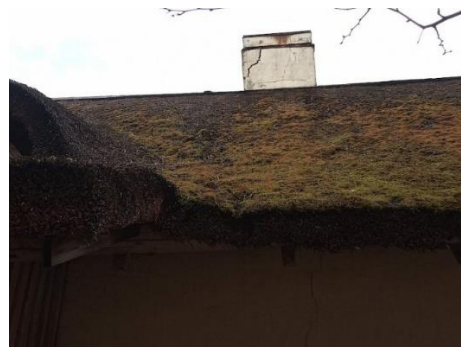
Joonis 36. Katuse põhjapoolne külg, kus on lisaks samblale samuti neeluga seotud kahjustus, vesi on tekitanud katusesse renni. Katuseosa on tehtud 1968.a. Autori foto.
