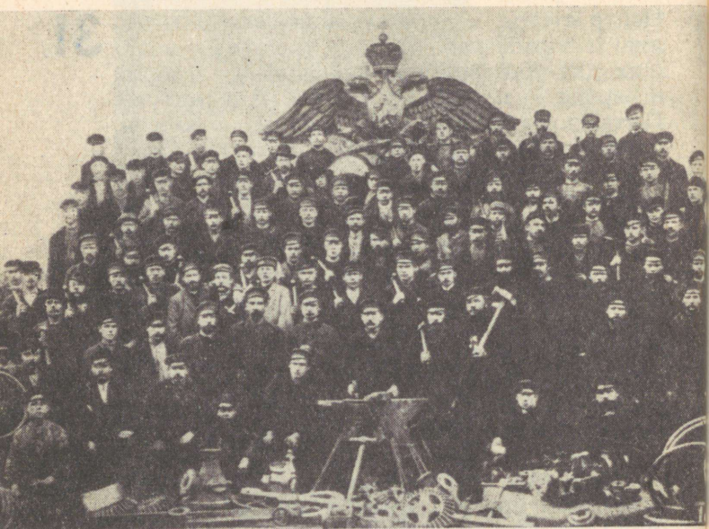
Рабочие машиностроительного завода Фр. Круппа
