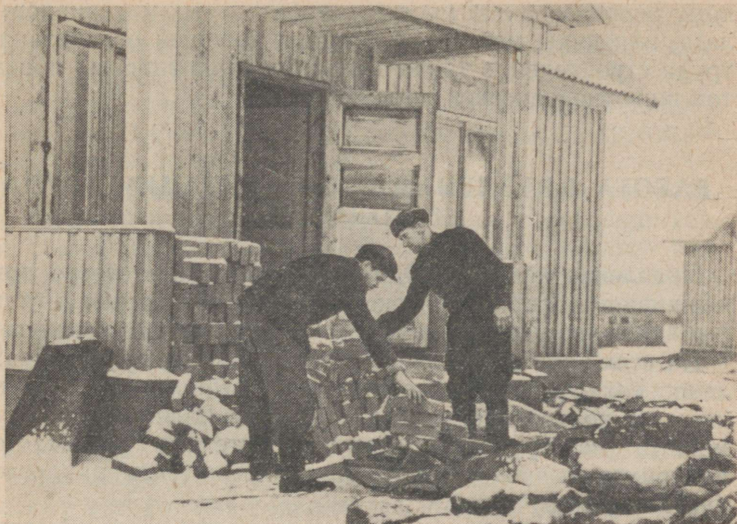
Строительная бригада заканчивает последние работы у нового дома.
