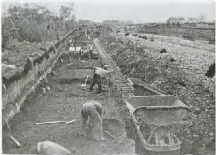
Kohtlan polttokivikaivos. Tuottoiset kerrokset avautuvat suoraan lähellä maanpintaa, joten kiveä nostetaan avonaisissa kaivoksissa. (V.K.K.)
