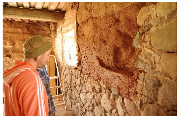
Täiteseguga täitmine ja saviplokkidele tasapinnalise aluse vormimine. Foto: M. Tominga 2016.
