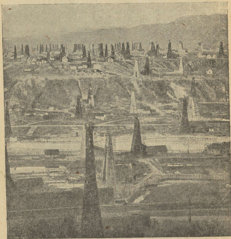
115. joon. Rumeenia õliallikad. Õli hangitakse puur-aukude kaudu; nende kohale on ehitatud puutornid. Nafta juhitakse vabrikuisse puhastamiseks ja ümbertöötamiseks.
