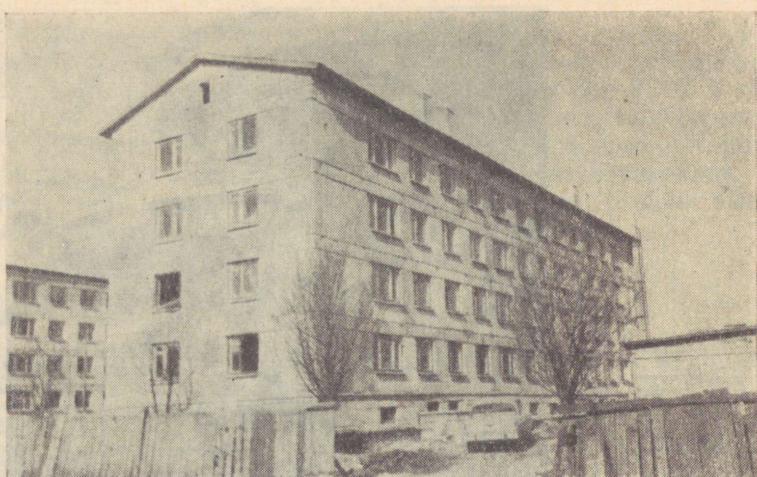
Рис. 4. Жилой дом из крупных газокермитовых блоков.
