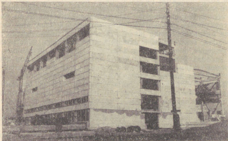
Рис. 5. Котельная брикетного завода «Ору» с наружными стенами, из газокукермитовых панелей.
