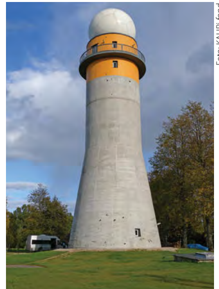
◇ 6. Sürgavere radari torn: ilmaradar avati siin 2008. aasta kevadel. Selle abil on võimalik hinnata pilvede liikumist, pilvedes sisalduvaid sademeid, tuulte kiirust ja suunda
