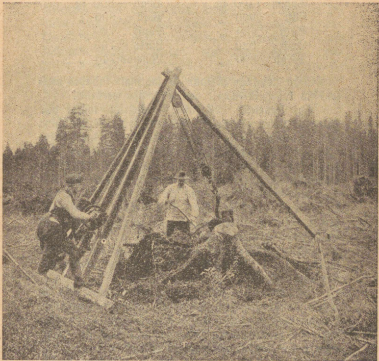
Wilt 4. Rännu juurimise masin „Dätten“ (Hiiglane).
