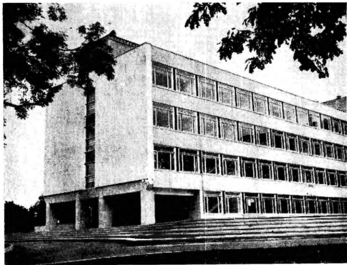
Крыло нового физического корпуса со стороны улицы Тяхе
