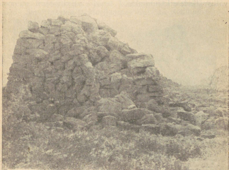
Joonis 11. Hooletult tehtud alusturba-aun. Auna hari ja külg on varisenud.
