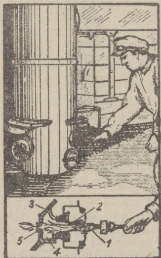
Joonis 78. Gasogeeni läitmine.
