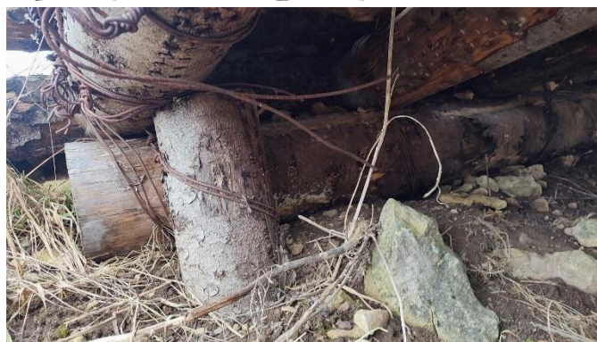
Joonis SEQ Joonis \* ARABIC 30 Pinnaga kontaktis oleva konstruktsiooni vaade ja pindmised kahjud II (autori looming, 2025)
