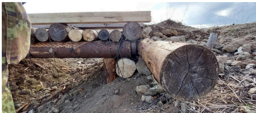
Joonis 20 Otsapalk (autori looming, 2023)
