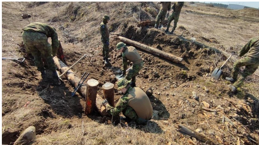
Joonis 19 Vundamentpalgi fikseerimine (autori looming, 2023)
