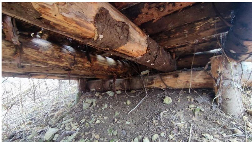
Joonis 27 Pindmised hallituskohad (autori looming, 2025)
