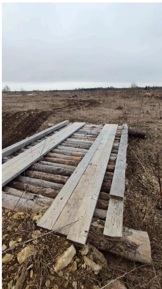
Joonis 28 Silla pealse ülevaade pärast kahte aastat (autori looming, 2025)
