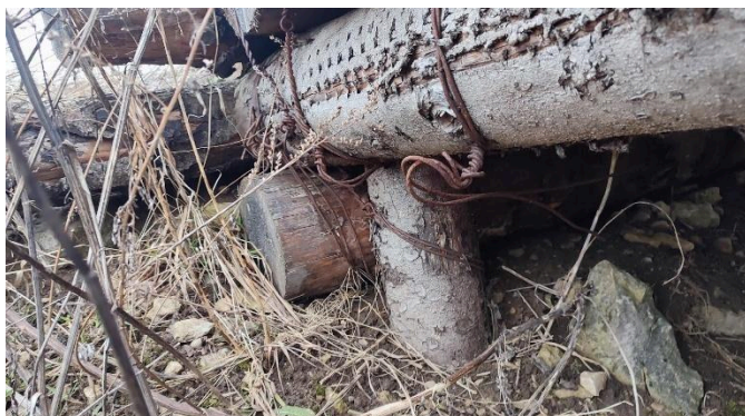
Joonis SEQ Joonis \* ARABIC 30 Pinnaga kontaktis oleva konstruktsiooni vaade ja pindmised kahjud II (autori looming, 2025)
