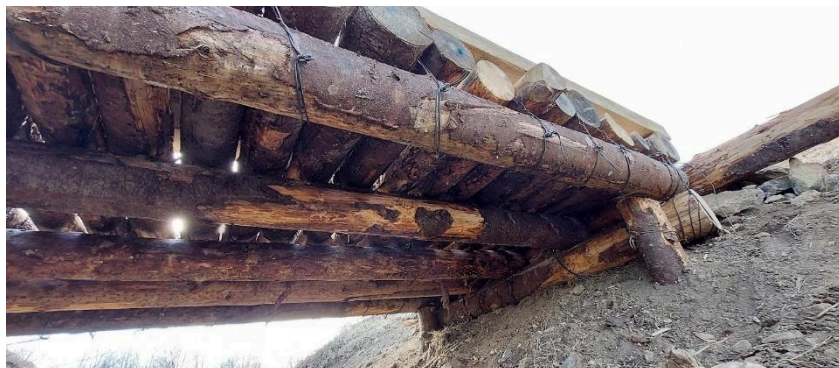
Joonis 22 Puitsilla pikitalade konstruktsioon (Kaspar Merisalu, 2023)
