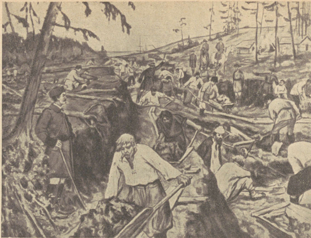
Laadoga kanali kaevamine. Moravovi maali järgi.
