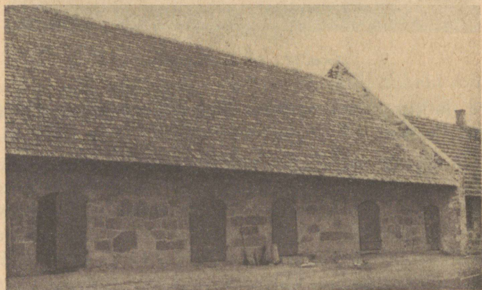
Joon. 58. Taluhooneid suuremas Sakala talus.
