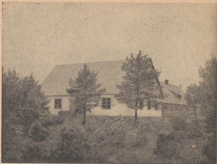
Joonis 2. Kingissepa rajooni Lembitu kolhoosi sigala 15 emisele. Köögiaosa on ehitatud betoonist õõnesplokkidest, sigaderuum puidust sõrestikseinaga.
