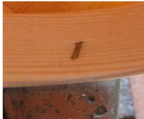
Joonis 60. Korrekselt löödud nael seestpoolt vaadatuna Foto: E. Tooming
