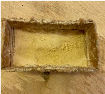
Joonis 108. Puutolmu kasutatakse korviviigade parandamiseks Foto: E. Tooming
