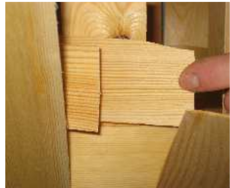
Joonis 133. Vahelaastude lisamine Foto: E. Tooming
