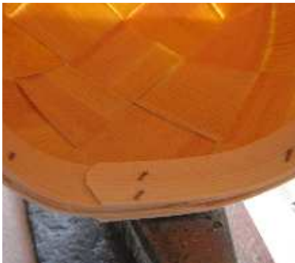
Joonis 61. Tagasikeeratud naelad lukul Foto: E. Tooming
