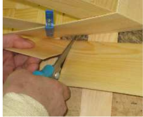
Joonis 125. Laastuvöö lõikamine Foto: E. Tooming
