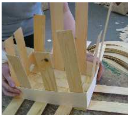
Joonis 122. Laastuvöö asetamine Foto: E. Tooming
