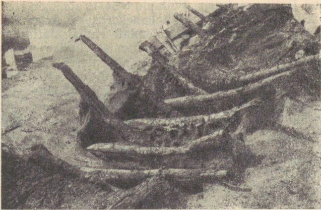
Joon. 2. Vaade drenaazkraavi lõigule Raekoja platsil pärast katteahade kõrvaldamist.
