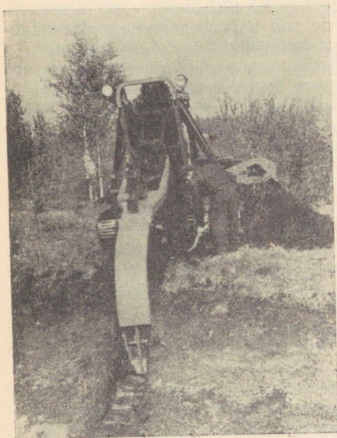
Joon. 13/14. Tallinna Ekskavaatoritehases ehitatud drenaažkraa- vi-ekskavaator tööta- mas Viljandi rajooni kolhoosis «S ä d e» 1957. aastal.
