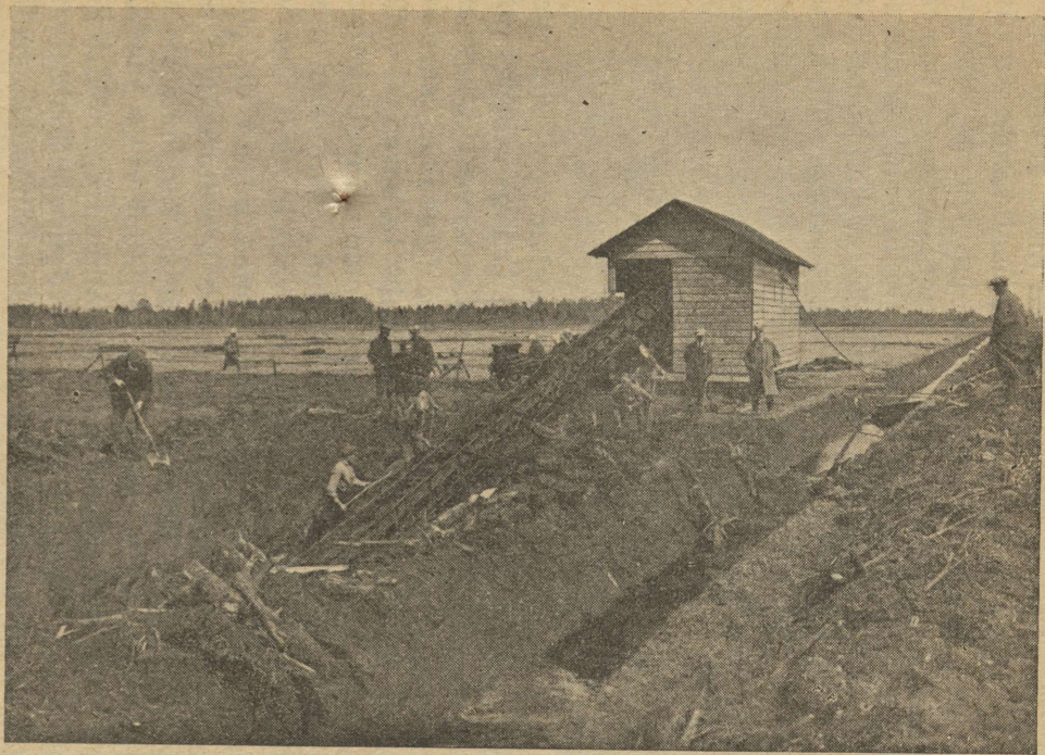
Pressturba väljatöötamine transportöoriga varustud „A n e p“ süsteemlise pressiga, elektrijõu abil.
