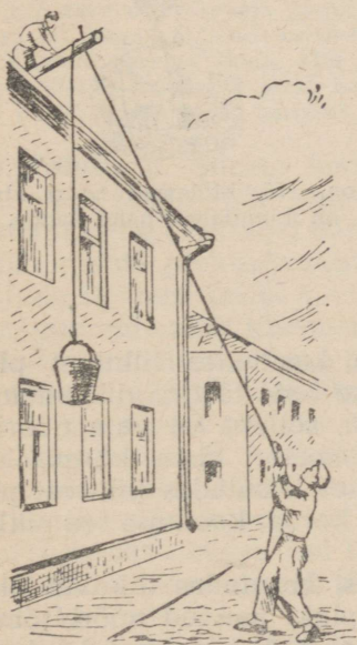
Joon. 112. Üle põikpuu on visatud nõõr, mille ühes otsas ripub koormus, teist aga tõmbab tööline.
