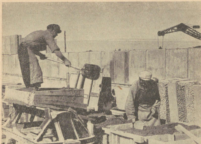
Joon. 25. Korebetoonist suurplokkide vormimine Keila sovhoosi veiselauda ehitamisel.
