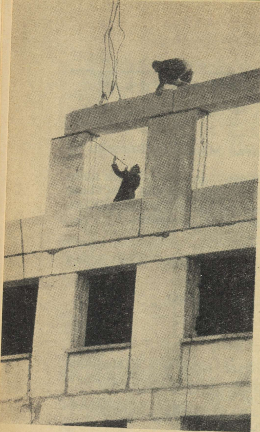
Joonis 4. Silikaltsiitmajade püstitamine.
