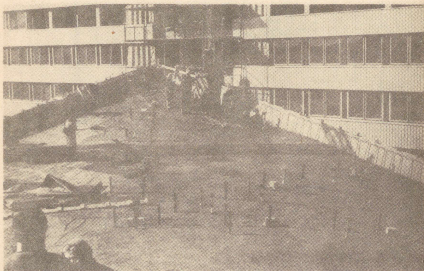
Фиг. 11. Окончание бетонирования и измерительные базы
