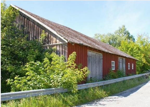
Foto 8. Restu vesiveski (Allikas: Restu... 2020)
