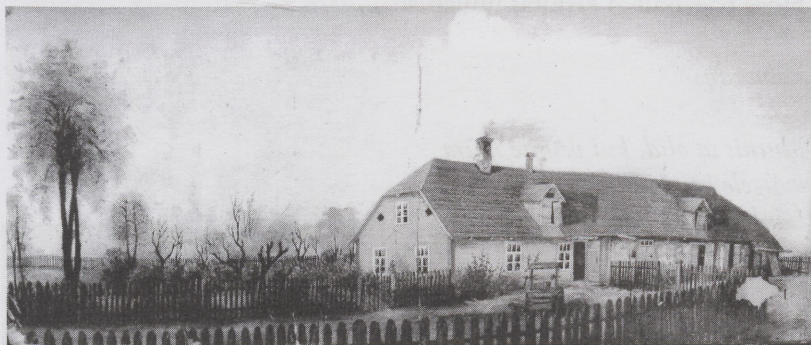
B. Rekandi maal talust Pikasilla 16B.
