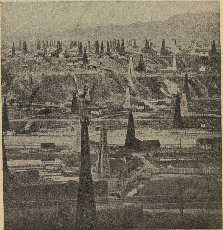
51. joon. Rumeenia õliallikad. Õli hangitakse puur-aukude kaudu; nende kohale on ehitatud puutornid. Nafta juhitakse vabrikuisse puhastamiseks ja ümbertöötamiseks.
