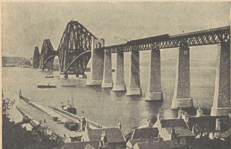
104. joon. Firth of Forth'i sild Inglismaal, 2,5 km pikk, üks maailma pikemaid sildu. Kahe keskmise kaare laius 520 m kumbki. Ehituskunsti imetöö.
